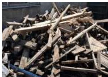
32: Ločevanje gradbenih odpadkov - lesa
