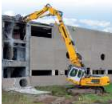
Slika 15: Strojno rušenje z bagrom
