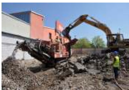
34: Obdelava gradb. materiala na gradbišču
