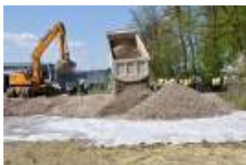
46: Izvedba nasipa iz gradbenih ruševin
