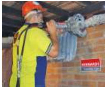
Slika 10: Hidravlični drobilec za beton
