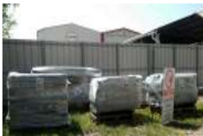
28: Odstranitev nevarnih odpadkov - azbesta
