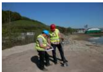
47: Kontrola kakovosti vgrajenega nasipa
