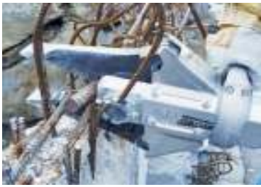
Slika 9: Hidravlične škarje
