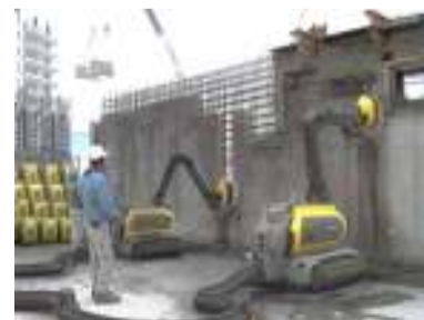
Slika 14: Rušenje betona z robotsko tehniko
