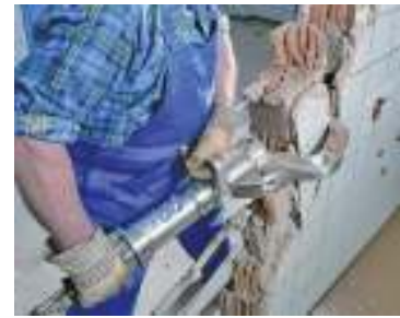
Slika 11: Hidravlični drobilec za opeko
