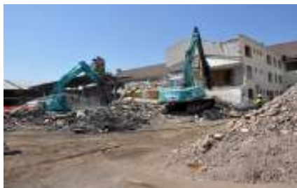
31: Mehansko rušenje objekta
