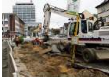
Slika 21: Žlični hidravlični bager
