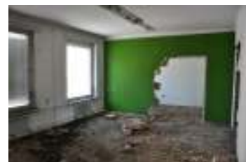
30: ...vseh instalacij, notranje opreme
